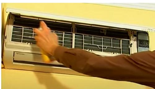
Quest'attività va fatta a macchina spenta. Prima di rimontare i filtri, spruzzare prodotti appositi sui pacchi lamellari o batteria di scambio (vedi figura) Con un panno, poi, rimuoviamo i residui che si sono venuti a creare sia all'interno che sulle alette. A
